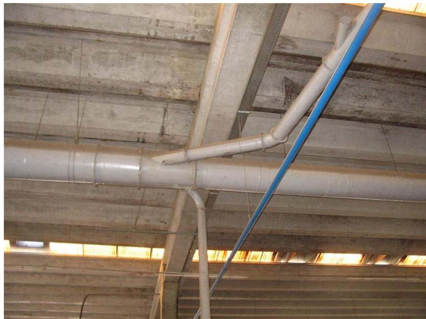
**Figura 6. 29** - Junção no sistema de ventilação local exaustora da Formaplas, Palhoça, SC.
